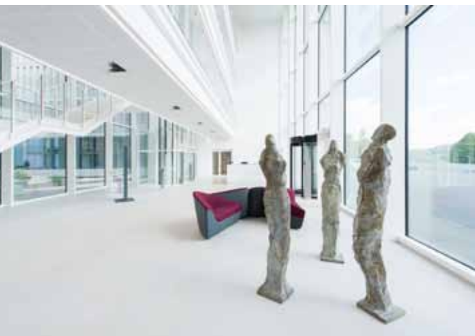
Das Foyer ist stützenfrei, weil die Brückenstege von der Decke abgehängt sind. Um die Lasten der Brückenstege aufzunehmen, wurde die Deckenplatte mit vier Ortbetonbalken als Überzüge verstärkt. Skulptur „3 Bürger“ von Heinrich Brockmeier
